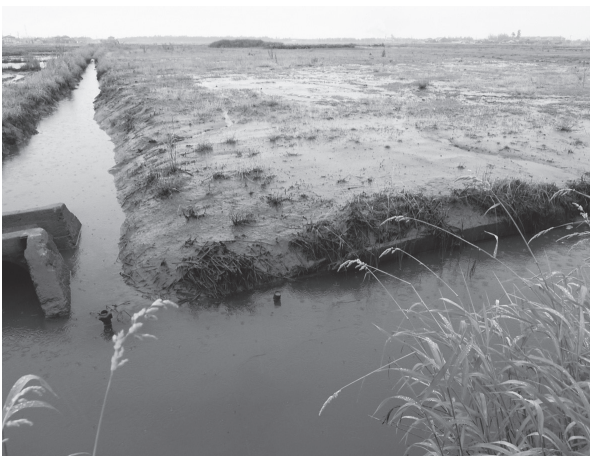
図1. 大震災後(2012年6月19日撮影)の名取川河口域井土地区の田圃および用水路の様子。元の田圃であった部分は土砂で埋まり、畦を超えて用水路内に砂泥が堆積している。この時点では用水路の流量は大震災前と同レベルであった。
