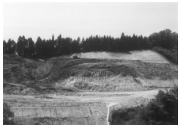
図6 土地改変のようす。 仙台市泉区泉インターチェンジ付近にて。
