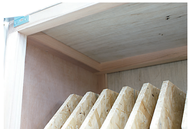
図4 骨組みに貼ったベニヤ板
