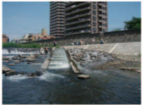
写真7 郡山堰に設置された仮設魚道の様子
