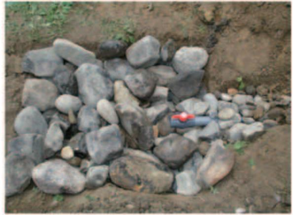
写真5 ビオトープ池外側に設置した浸透部の様子
