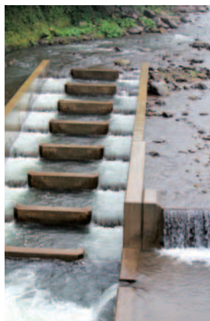
写真7 知床半島羅臼川砂防ダムに新設されたコンクリート製魚道。
