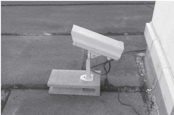
図2 ブロックで固定したカメラハウジング
